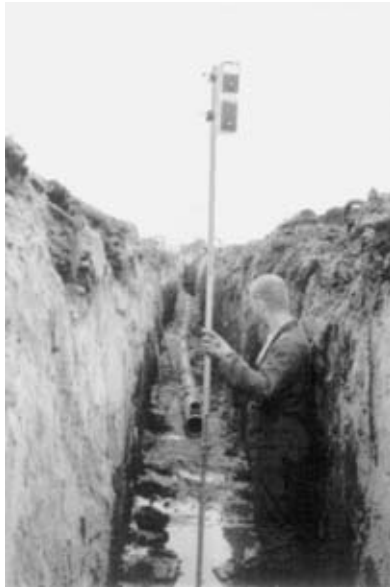
Fig. 4.8 Met behulp van een laser zorgt men ervoor dat de rioolleiding op de juiste diepte komt te liggen.
